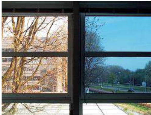
خلايا الكهروضوئية Photovoltaic-Cell نصف شفافة تستخدم في الأسقف والواجهات، وهي خلايا تولد الكهرباء عن طريق الشمس. حيث تعتبر الخلايا الشمسية محولات تأخذ طاقة من أشعة الشمس وتخزنها في مولدات لانتاج الكهرباء وتعكس كمية كبيرة من الاشعاع
